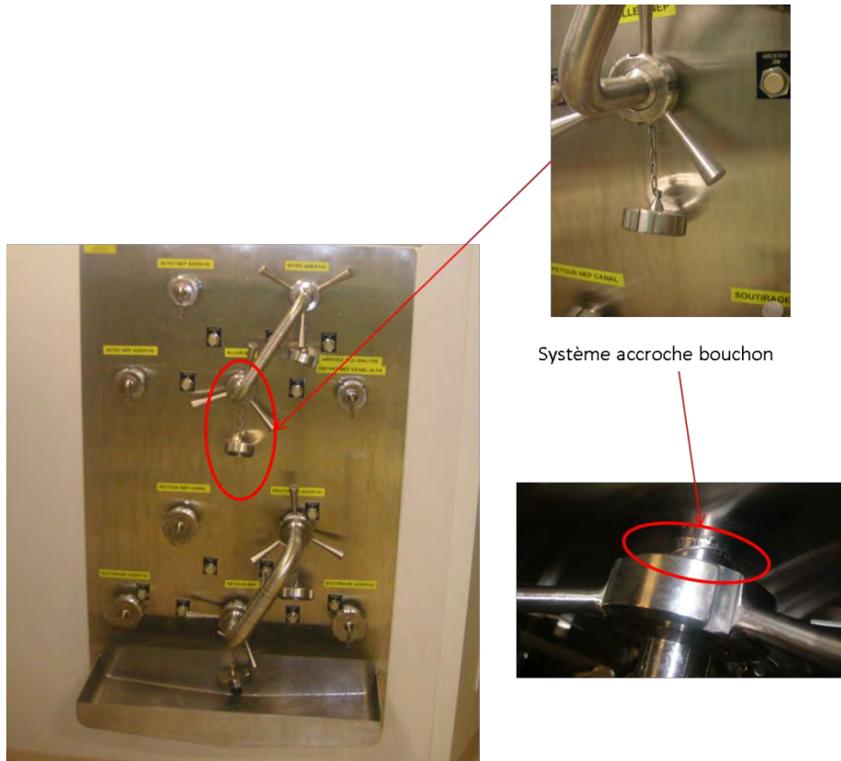
Figure 42 : Exemple d'un tableau de pontage complet, disposant du nouveau système d'accroche.
