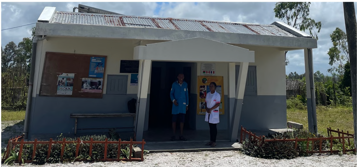
Figure 3 : Photographie du Centre de Santé de Base 1 d'Ambavarano
