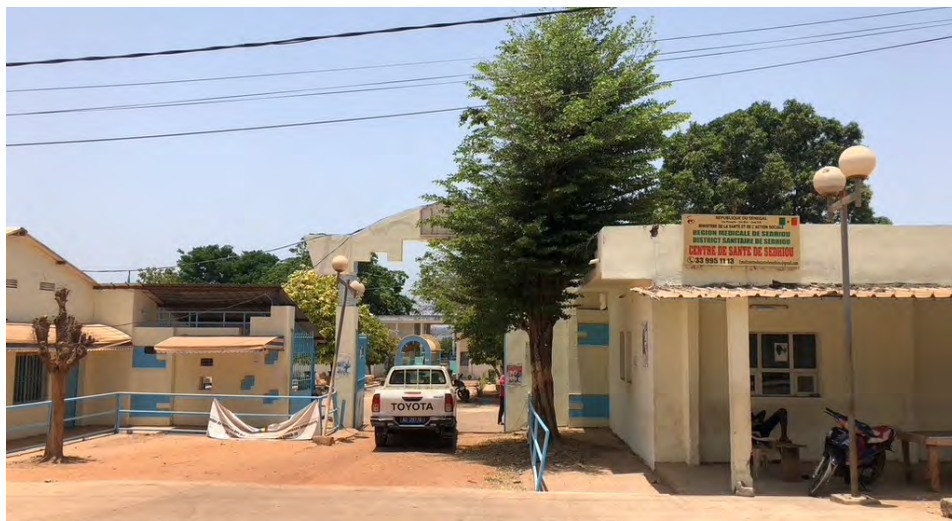
Figure 12- Centre de santé de Sédhiou (Source : photo personnelle)
