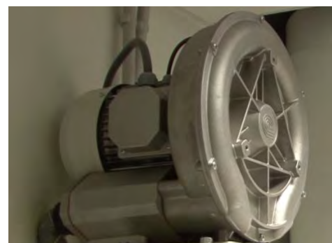
Figure 18. Photographie d'un moteur de pompe à salive Techno-Jet (CATTANI) 1
