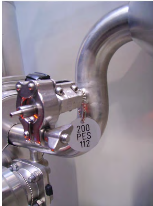
Figure 23 - Point de prélèvement standardisé sur la boucle d'EPPI
