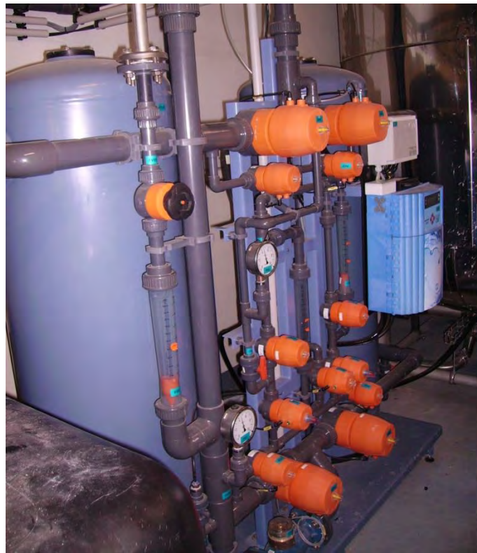
Figure 19 - Adoucisseur à régénération automatique
