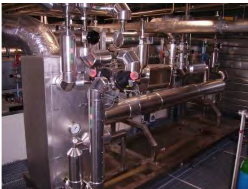
Figure 22 - Echangeur d'une sous-boucle froide
