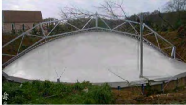
Figure 14 : Couverture de fosse à lisier (49)
