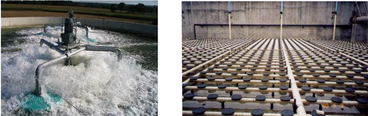
*Figure 12 - Image de gauche : Bassin biologique aéré à turbine flottante. Image de droite : Bassin biologique aéré à diffuseurs. Schémas issus du support de cours « Traitements secondaires dans le traitement des effluents », M. Fernandez, 2019 [79].*
