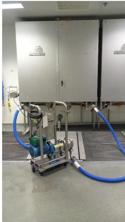
Figure 29 : nettoyage d'une pompe sur le NEP de la laverie
