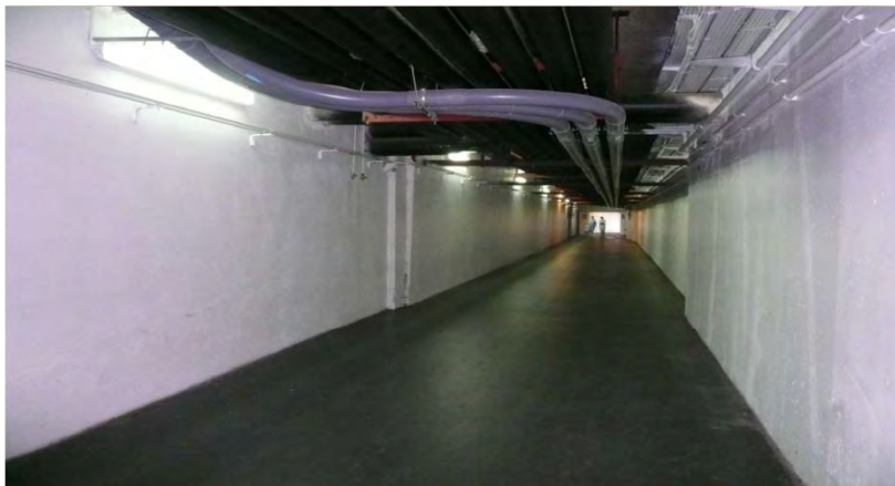
Figure 27 Photographie galerie souterraine
