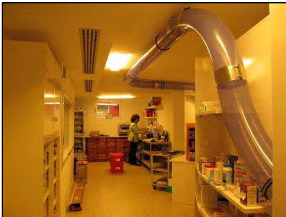
Figure 6 : Système de convoyage pneumatique Airtec de Tecnilab (33)
